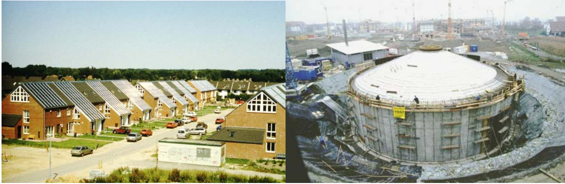
Bild 2: Solar unterstützte Nahwärmeversorgung mit Langzeit-Wärmespeicher in Hamburg (linkes Bild: Siedlung) und Friedrichshafen (rechtes Bild: Bau des Heißwasser-Wärmespeichers)
