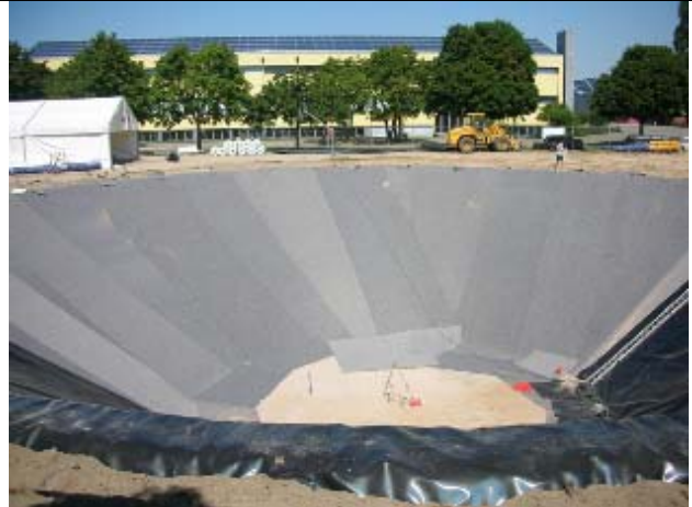
Schutzvlies und äußere, verschweißte Kunststoffbahn
