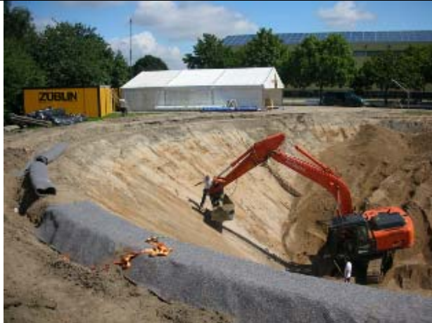
Ausheben der Speichergrube
