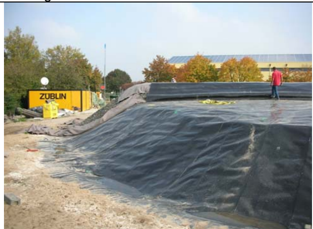
Aufbau der Deckeldämmung aus Schaumglas-schotter auf innerer Lage Kunststoffbahn. Abdeckung der Wärmedämmung mit äußerer Kunststoffbahn
