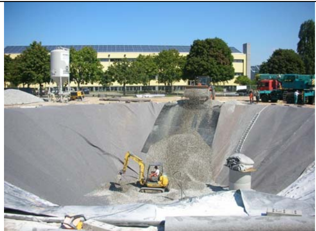
Innere Lage Schutzvlies, Einbau der unteren Kieslage
