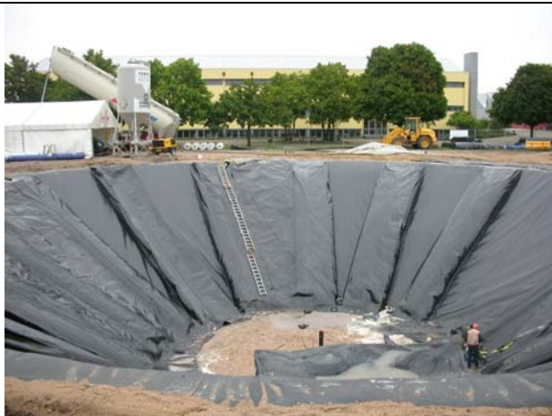
Innere Kunststoffbahn, erste Kammern mit Blähglasgranulat gefüllt
