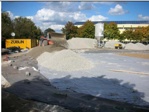
Mittlere Lage Sand ist eingebaut, Aufbau des oberen Kegelstumpfes aus Kies
