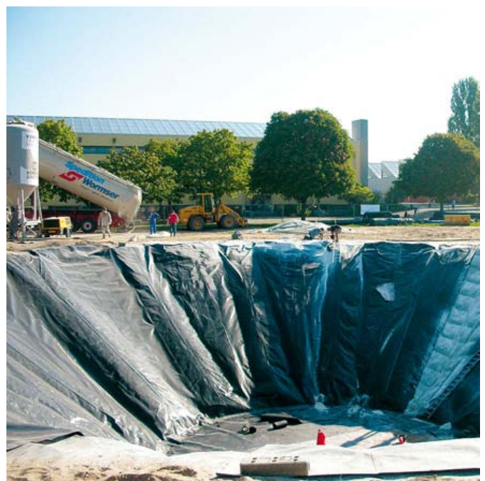
▼ Abbildung 6 Bau des Erdbecken-Wärmespeichers in Eggenstein
