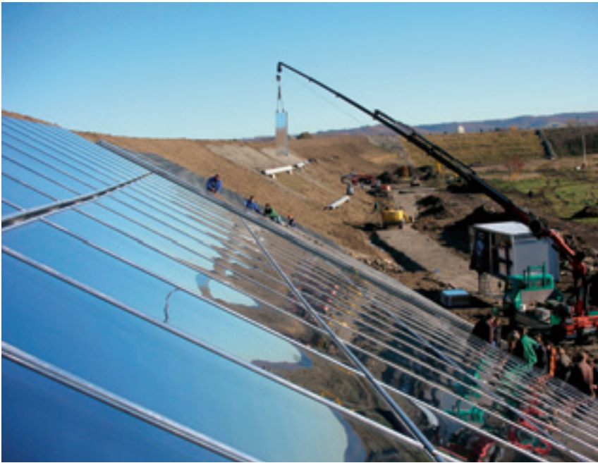
Abb. 5 Kollektorfeldmontage auf dem Lärmschutzwall
