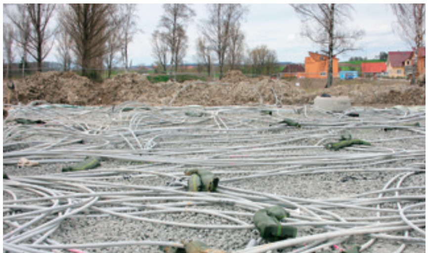
Abb. 11 Ausführung der Horizontalverrohrung auf Schaumglasschotterschicht
